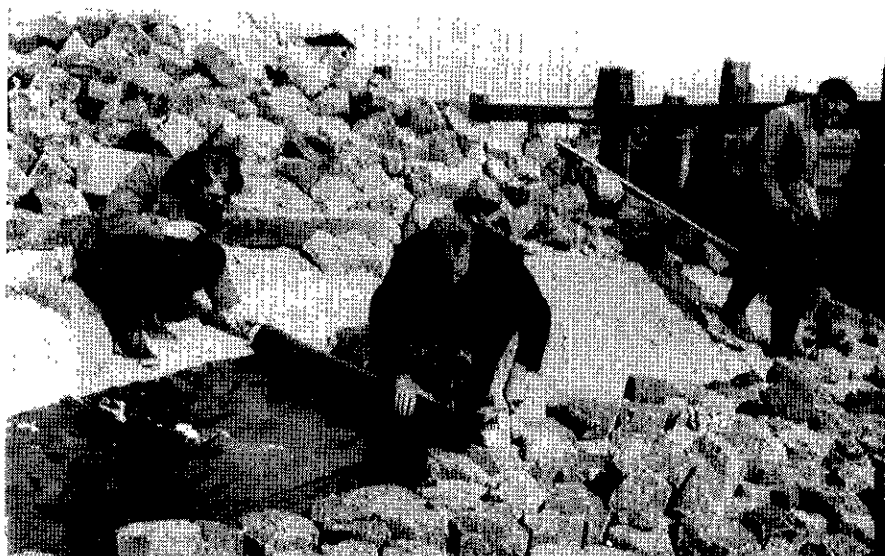
Het aanbrengen van de plastic folie
